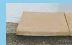
POSE DES MARGELLES
