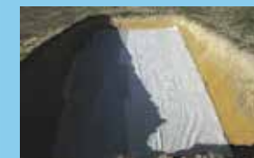
POSE DU GEOTEXTILE
