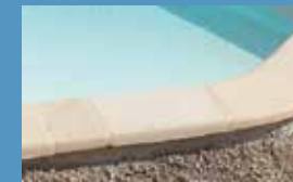
POSE DES MARGELLES
